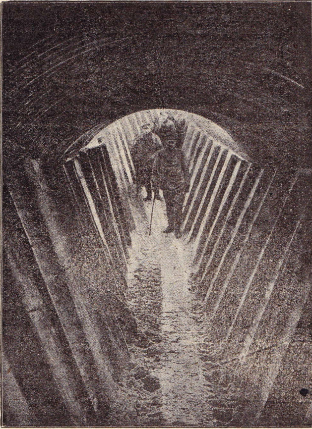
Kilometerlange tunnel-loopgraaf die tot de vuurlinie gaat.
